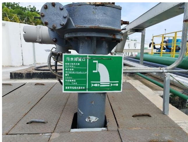
雨水排放口标志牌
